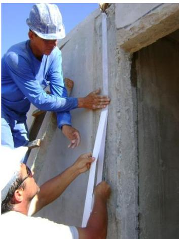
**Figura 31 – Colocação da fita sobre a junta**
