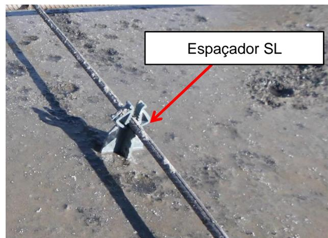
**Figura 8 – Espaçador tipo cadeirinha**
