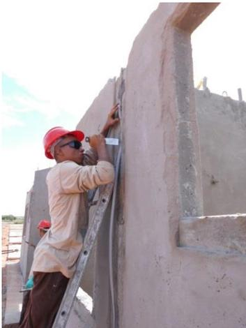
**Figura 29 – Colocação do fundo de junta**
