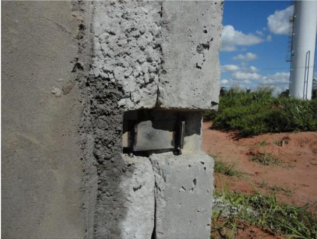
**Figura 27 – Chapa de ligação após a soldagem**
