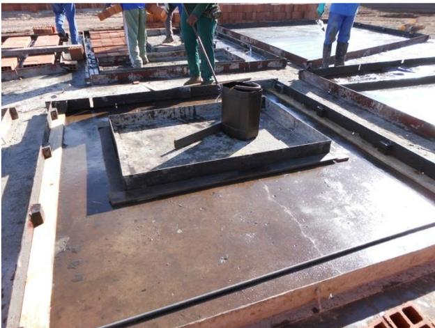
**Figura 15 – Limpeza e aplicação de desmoldante**
