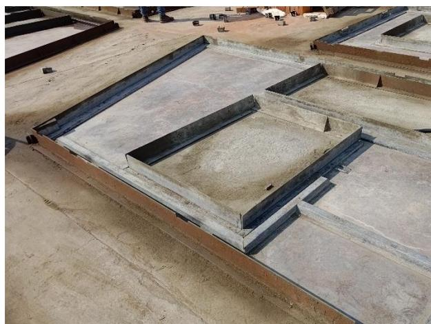
**Figura 3 – Quadro da fôrma sobre base de concreto**
