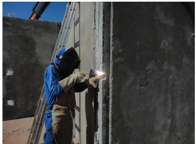
**Figura 26 – Soldagem das chapas de ligação dos painéis**
