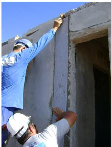
**Figura 33 – Colocação da tela de poliéster sobre argamassa e fita**
