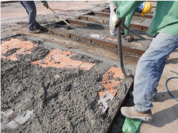
**Figura 19 – Lançamento e adensamento do concreto do quadro externo e das nervuras**
