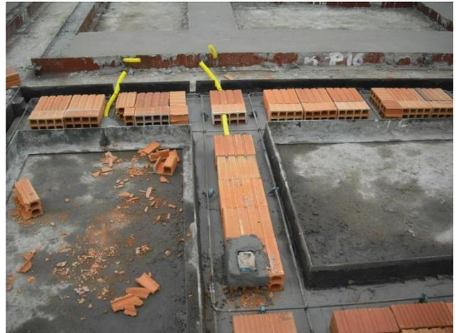
**Figura 20 – Eletrodutos e caixas elétricas embutidas no painel**
