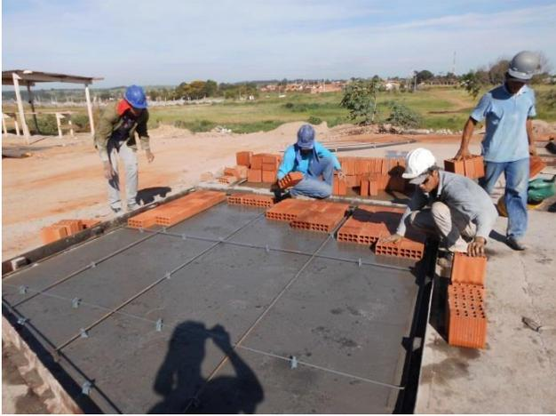
**Figura 17 – Colocação da armadura e dos blocos**
