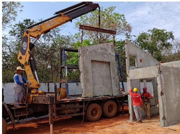
**Figura 5 – Montagem dos painéis**
